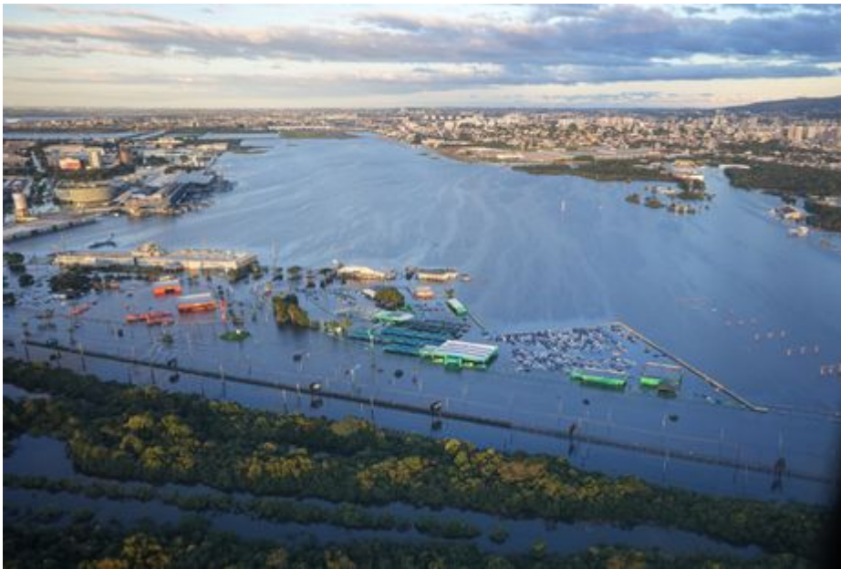
Aeroporto de Porto Alegre alagado pela enchente – Foto: Mauricio Tonetto/Secom
