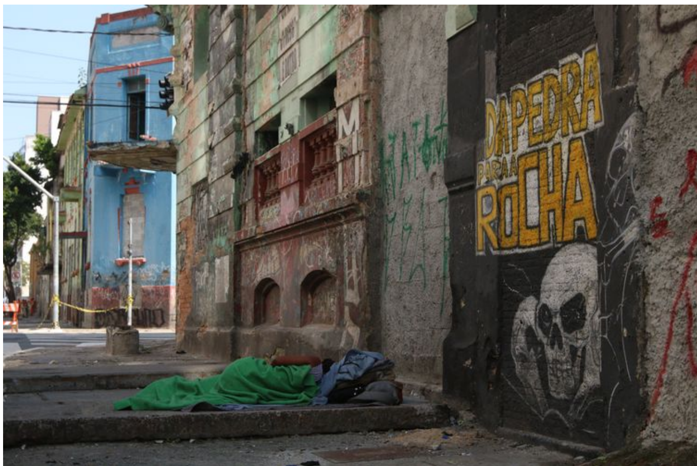
Casarões lacrados na rua Helvétia, região da Cracolândia, área central de São Paulo - Rovena Rosa/Agência Brasil
